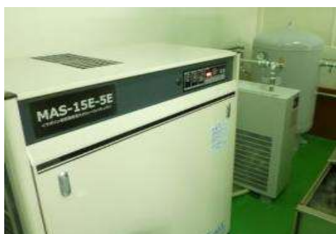
◆ 塗装ヘッド専用コンプレッサー+ドライヤー・レシーバートank
